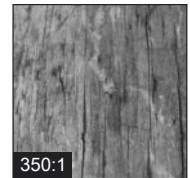
Superficie agrietada por estrés mecánico.
